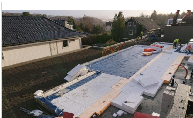
1.etasje med radonsperre, ringmur og grunnmur i vest er ferdigstilt i dag.
